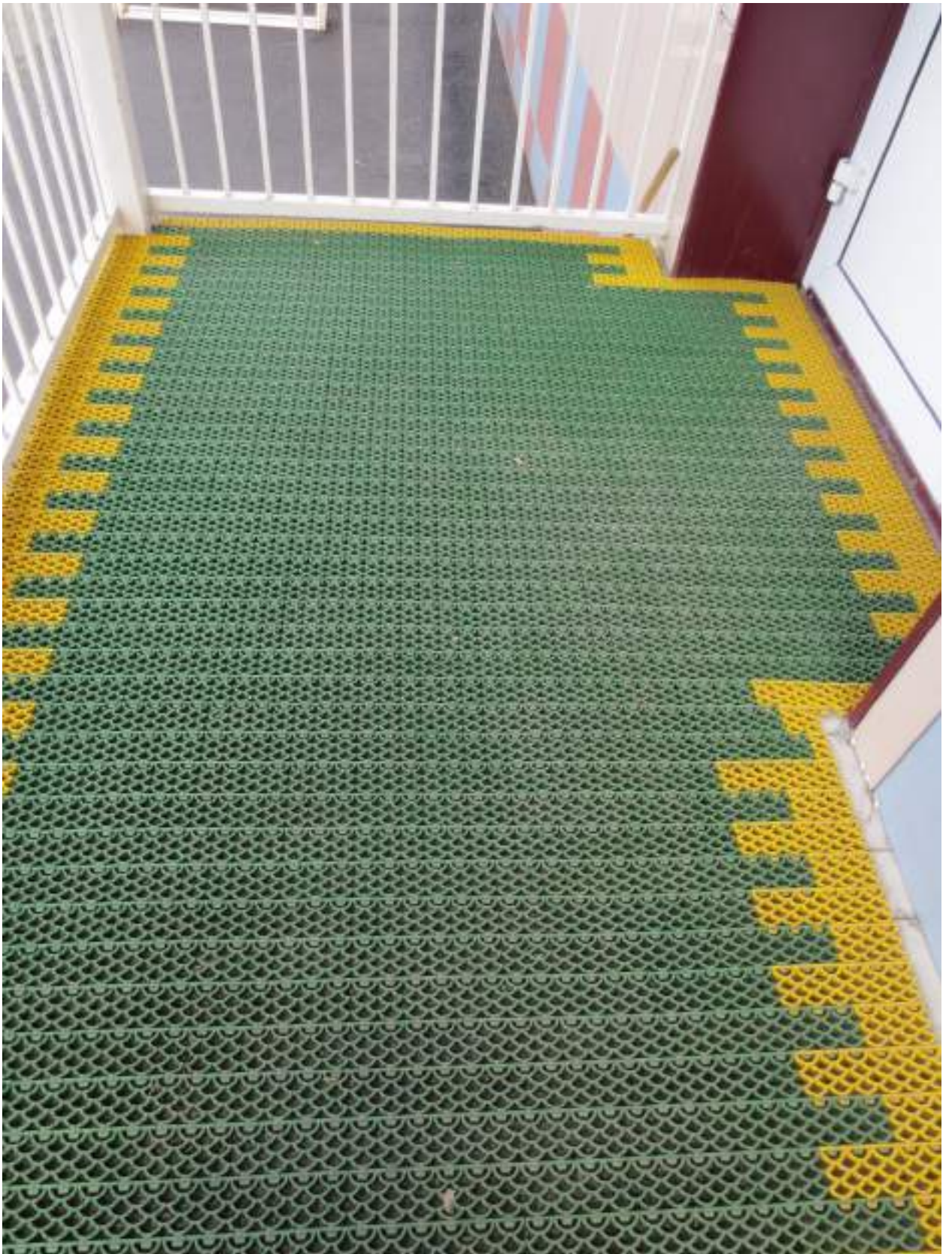
Входная площадка перед дверью, фото № 5
