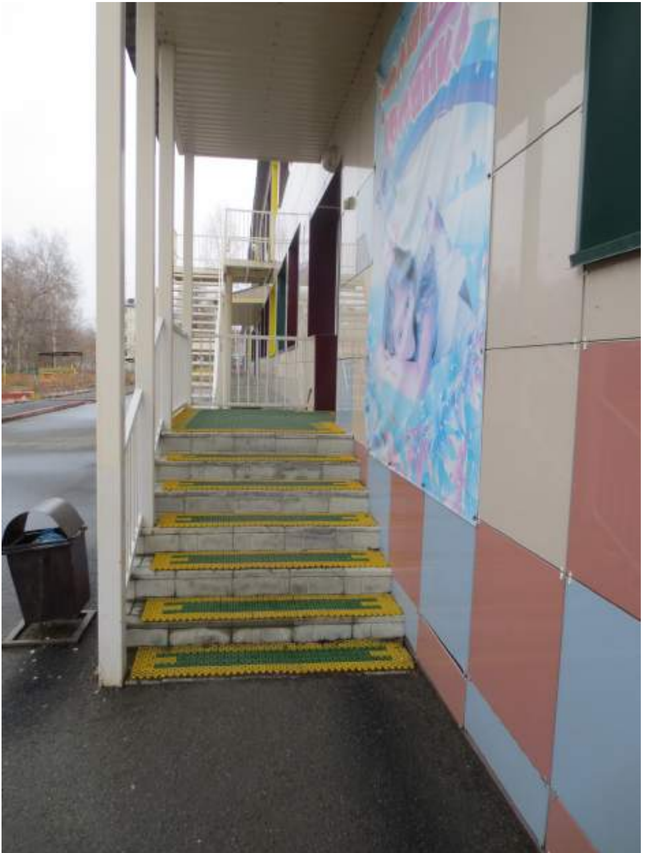
Крыльцо перед главным входом, фото № 4
